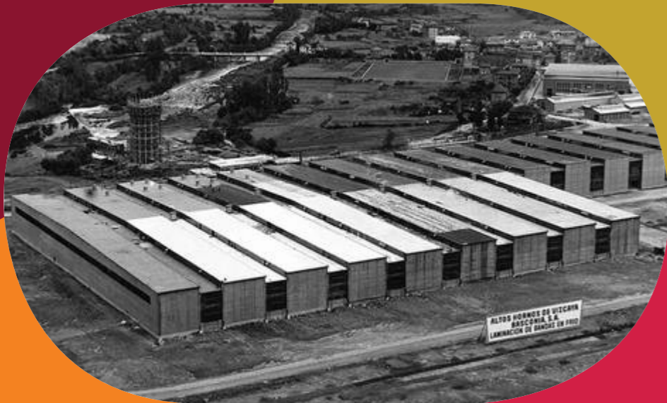
Imagen de la Fábrica de laminación de Bandas/ Bidebieta
